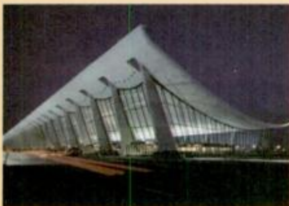
Techo del aeropuerto Dulles en Washing- ton (hipérbola y parábola)
